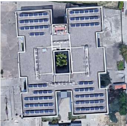
Figura 7.4. Instal·lació d'autoconsum dissenyada sense tenir en compte futures ampliacions.
